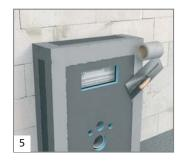
Traiter les joints et les raccords avec la bande d'armature wedi Tools.
