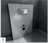
Le panneau d'habillage du bâti-support peut être carrelé directement après la pose de l'armature, sans traitement
