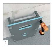
Une fois découpé, le panneau I-Board doit être fixé mécaniquement sur l'installation murale au moyen des vis à fixation rapide fournies et des rondelles d'isolation.
